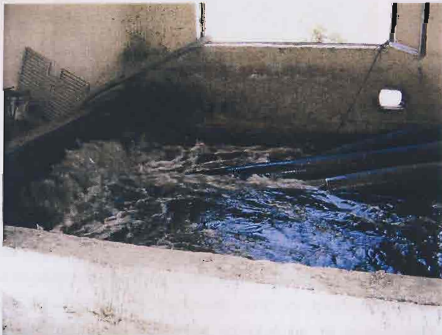
ΕΚΚΕΝΩΣΗ ΒΟΘΡΟΥΜΑΤΩΝ ΣΕ ΚΑΝΑΛΙ ΑΝΟΙΚΤΟΥ ΤΥΠΟΥ
