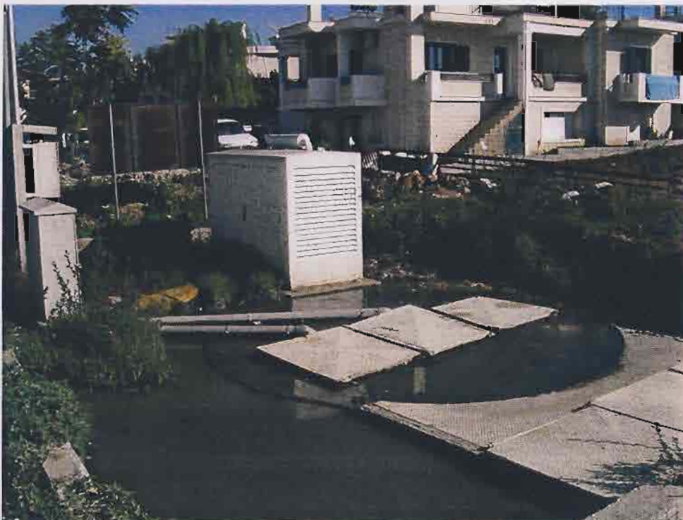
ΥΠΕΡΧΕΙΔΙΣΗ ΛΥΜΑΤΩΝ ΣΕ ΚΑΤΟΙΚΗΜΕΝΗ ΠΕΡΙΟΧΗ
