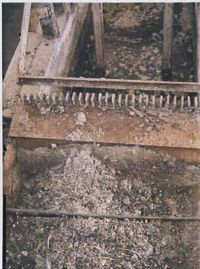
ΦΡΑΓΜΕΝΗ/ΕΚΤΟΣ ΛΕΙΤΟΥΡΓΙΑΣ ΜΗΧΑΝΙΚΗ ΕΣΧΑΡΑ ΛΥΜΑΤΩΝ
